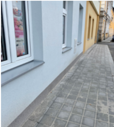
Rekonstrukce chodníku v Nerudově ulici.
