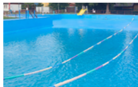
Oprava bazénové vany proběhne během podzimu.
