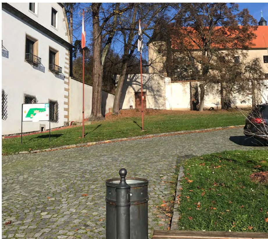
nevhodně umístěné prvky (stožáry, odpadkový koš); pohled na trafostanici
