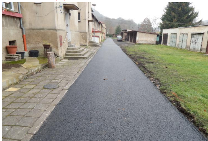
Nový povrch v ulici Nádražní
