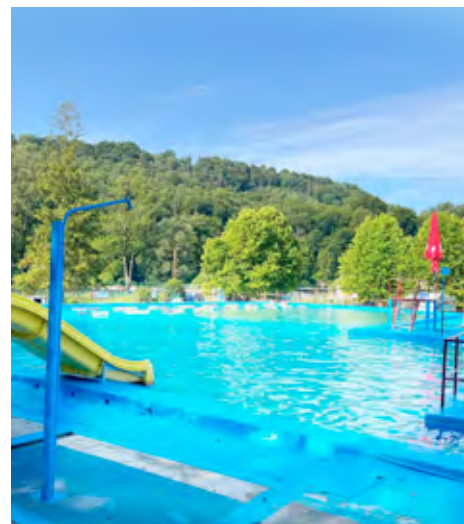
Oprava bazénové vany na koupališti.
