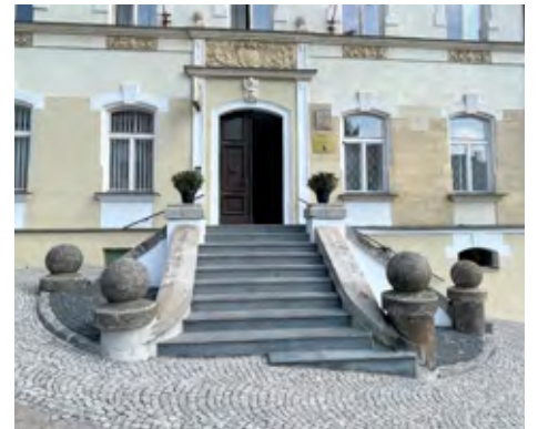
Opravené schodiště do budovy městského úřadu.
