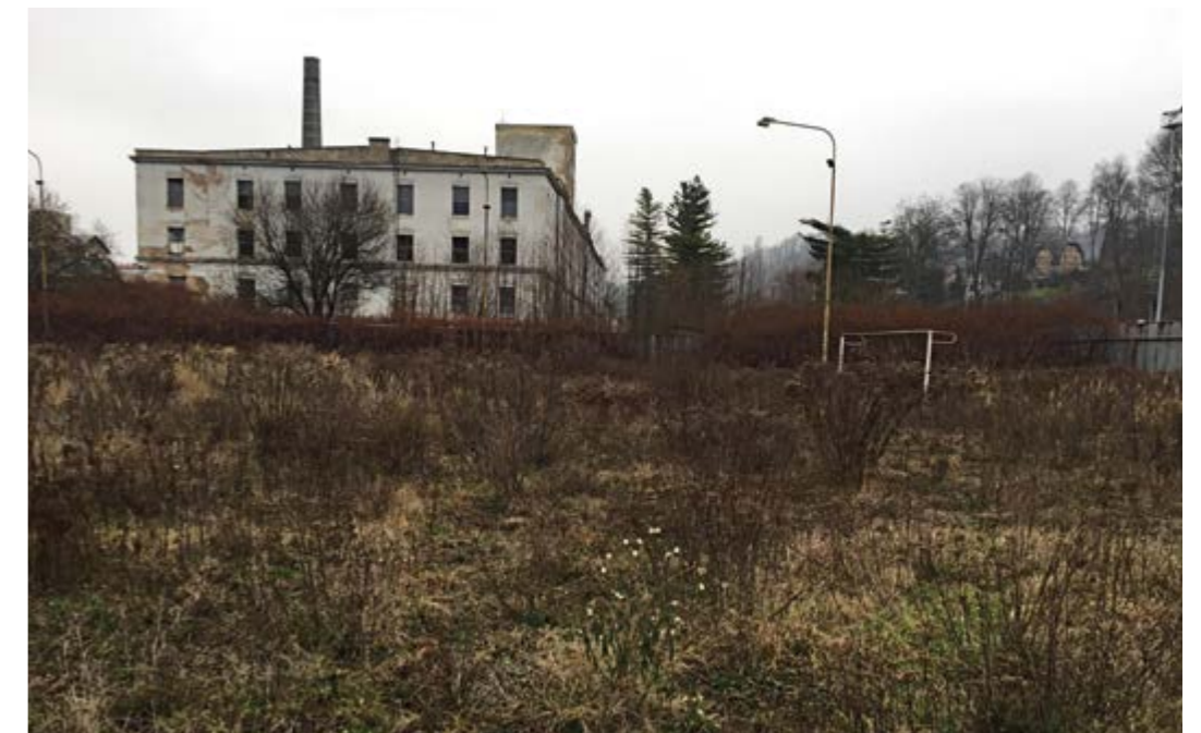
Brownfield v prostoru bývalého škvárového hřiště u továrny Benar.
