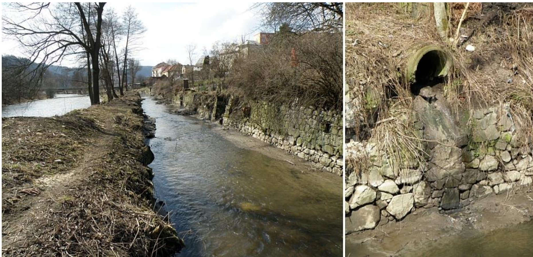
Vykácené stromy bez povolení, vypuštěný náhon, stále funkční stará kanalizace z domu v Děčínské ulici bez čištění.
