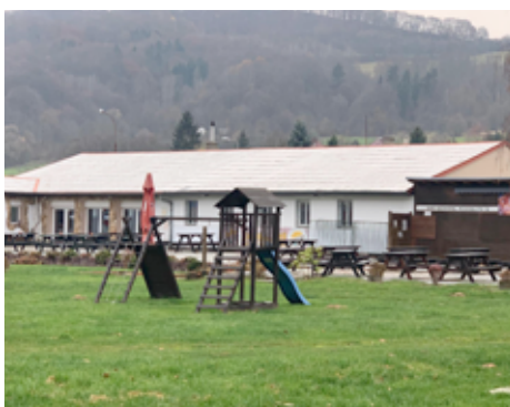
Oprava střechy objektu.
