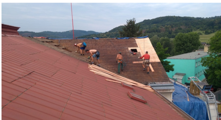
Oprava střechy na škole
