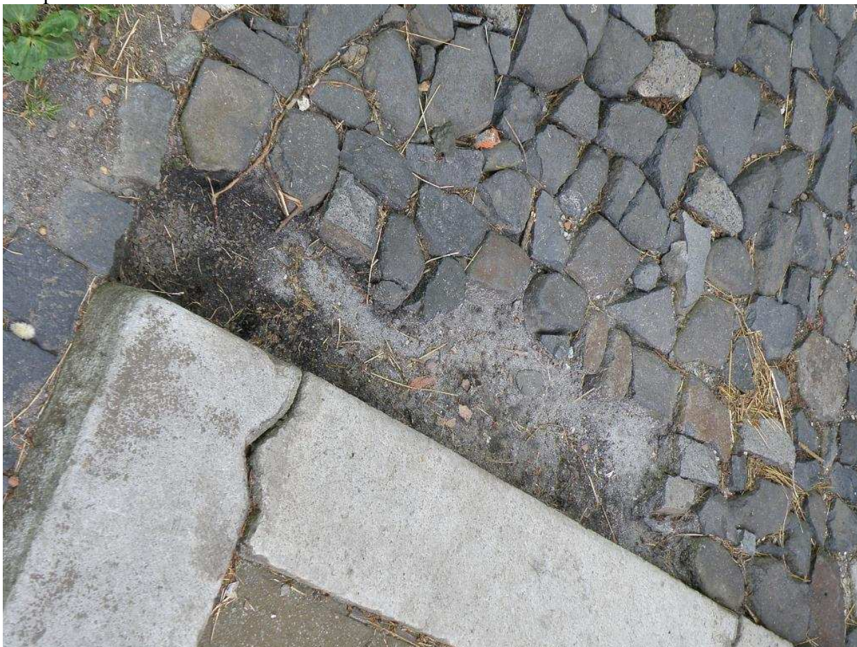
Fotopříloha č. 7 – dlažba u vchodu do kostela
