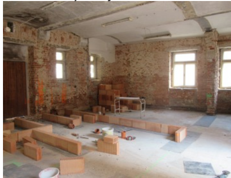
Prostory vedle bývalé kuchyně
