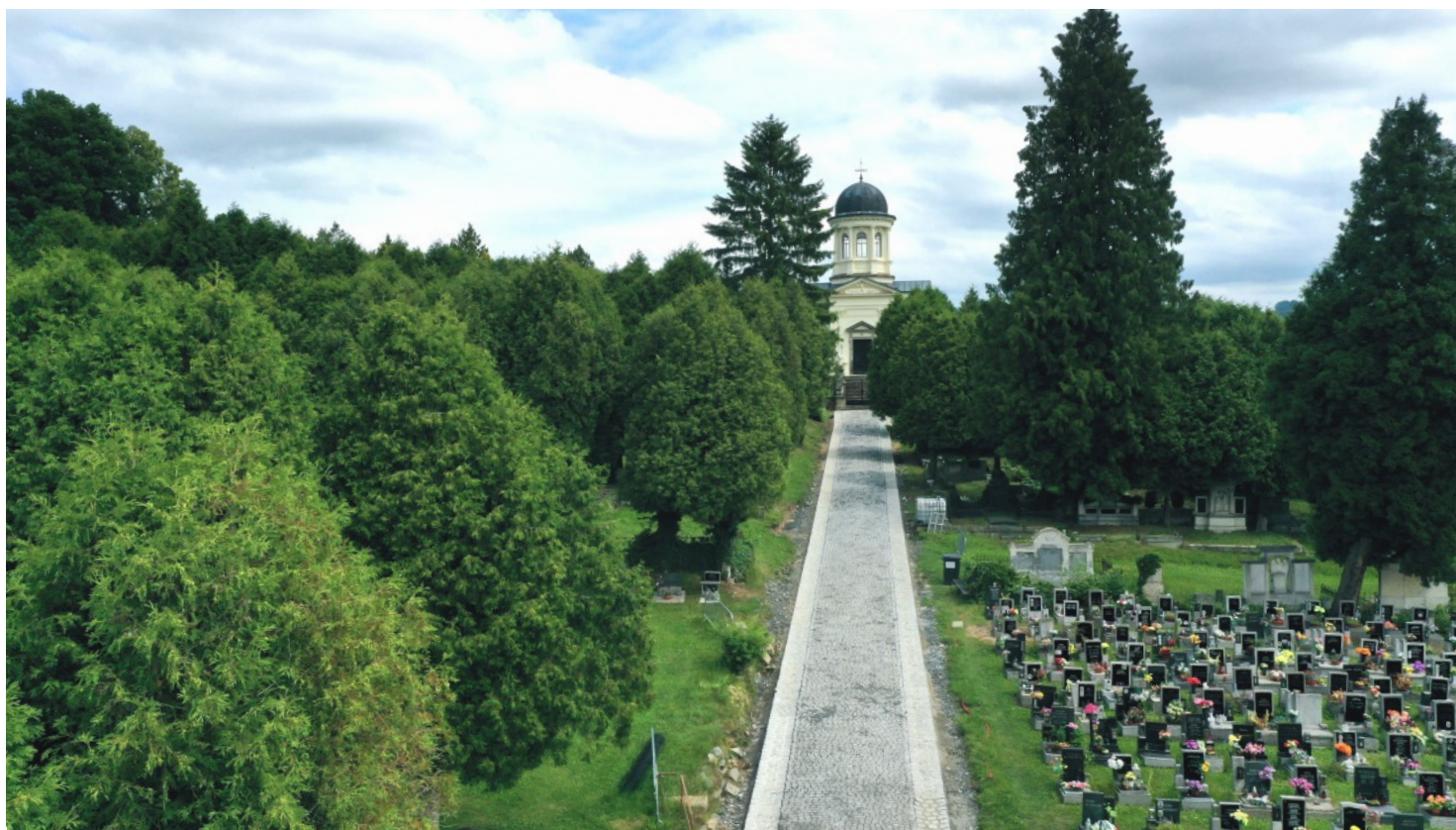
Rekonstrukce cesty na hřbitov pokračuje. Plánovaný termín kompletního dokončení prací je konec srpna.
