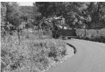
Oprava komunikace K Bottari, dodavatel Herkul, a.s. (odstraňování povodňových škod 2010). Foto: Karel Šohaj
