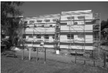
Mateřská škola - částečně dokončená fasáda jižního pavilónu, dodavatel Stamo, s.r.o.
