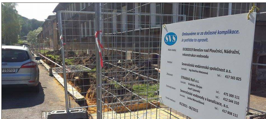
Rekonstrukce vodovodu v Nádražní ulici
