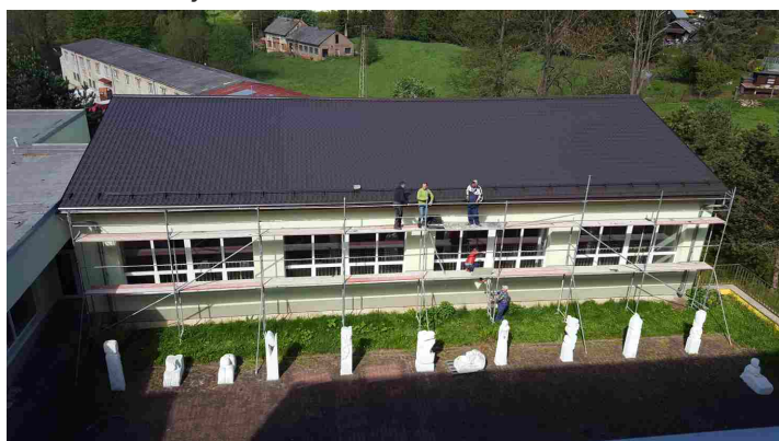
Opravená střecha budovy tělocvičny ZŠ
