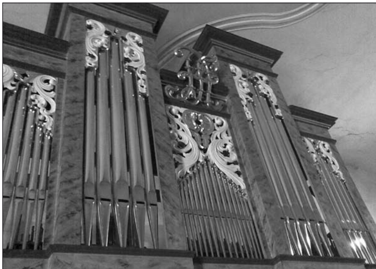
Na snímku Jaroslava Dostála jsou varhany po instalaci píšťal, které jsou z leštěného cínu, koruna ještě není instalována.
