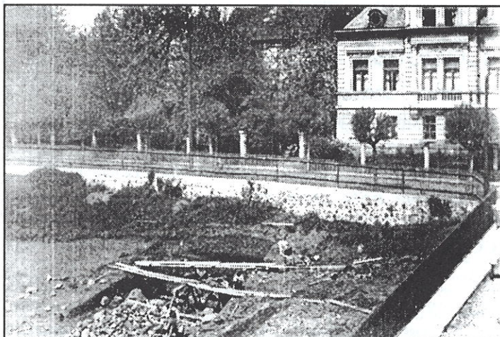
Hrnčířská planina těsně před zahájením stavby kina (duben 1927).
