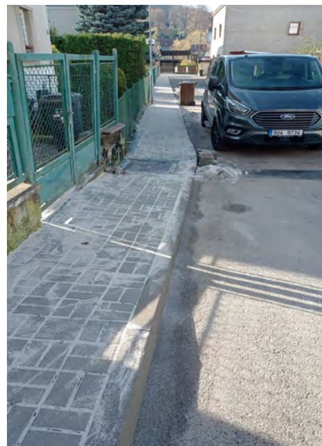
Hotová rekonstrukce chodníku v ulici Příčná.
