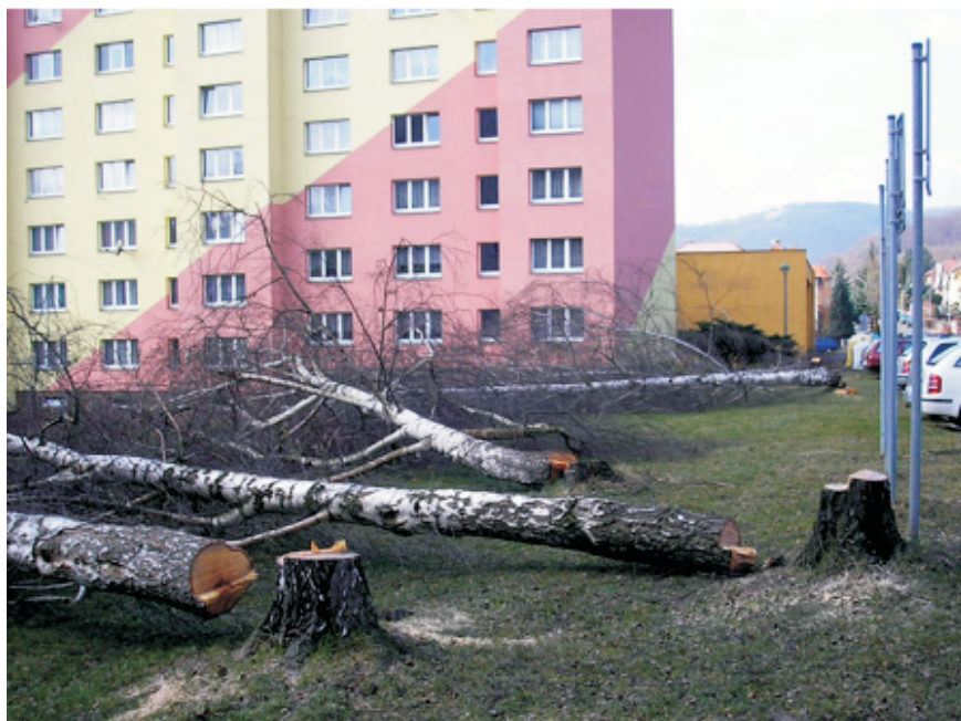
V rámci akce Biodiverzita sídliště proběhla první (a nejbolestivější) fáze. Nyní bude firma Ing. Kohák pokračovat výsadbou nové zeleně podle projektové dokumentace.
