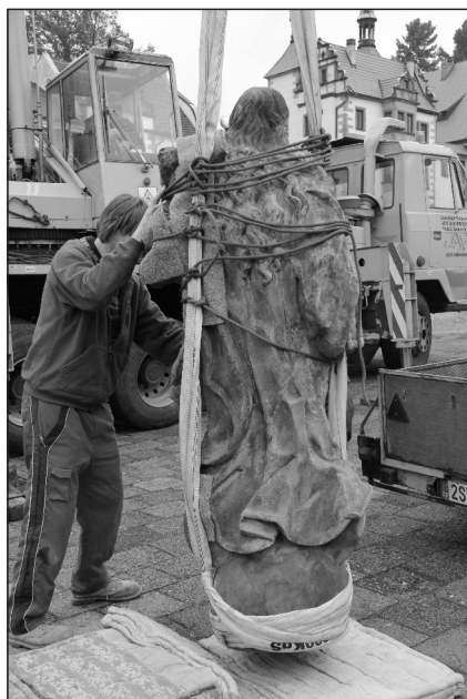
Průběh osazování vrcholové sochy Panny Marie zpět na sloup. Foto: Bc. Tereza Peerová, NPÚ, ÚOP v Ústí nad Labem.
