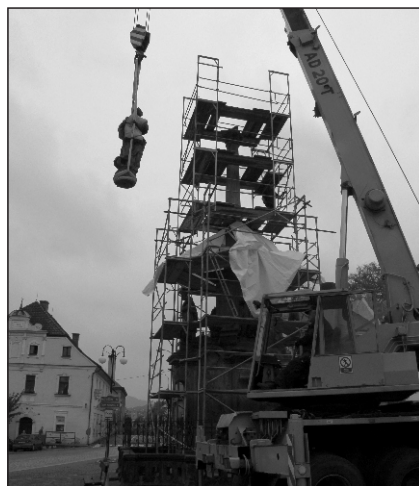
Průběh osazování vrcholové sochy Panny Marie zpět na sloup. Foto: Bc. Tereza Peerová, NPÚ, ÚOP v Ústí nad Labem.
