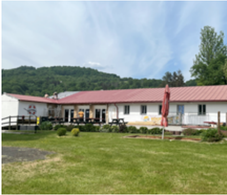
Hotová střecha objektu na koupališti.
