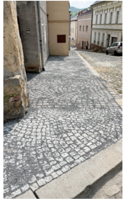
Nový chodník pod kostelem.
