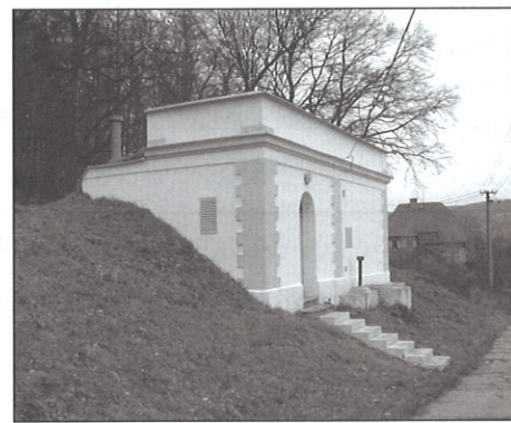
Rok 2000 - objekt po opravě.
