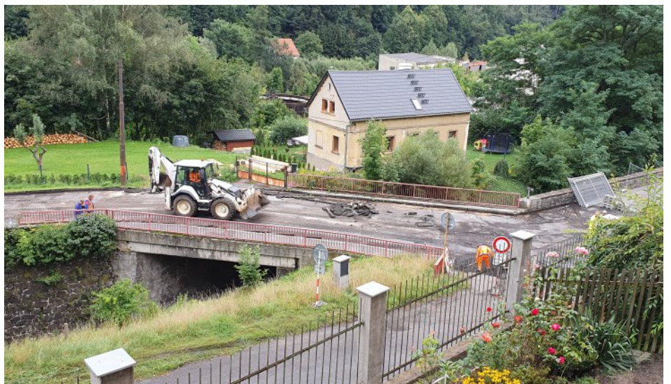
Práce na rekonstrukci mostu byly zahájeny 1. 9.
