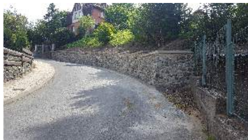
Opravená opěrná zeď na Sokolském vrchu
