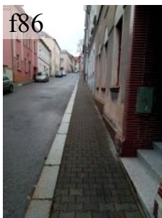
Částečně bezbariérový úsek chodníku v ulici Československé armády /příčný sklon 6-8 %/.
