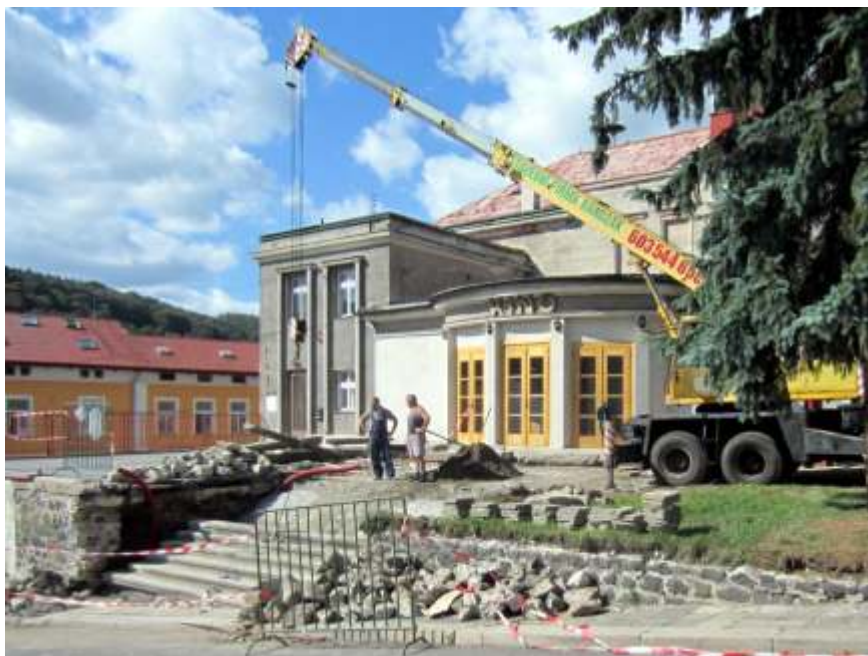
Práce před kinem pokračují. Bylo osazeno nové vstupní schodiště a opravena opěrná čedičová zeď, nyní dělníci připravují místo na pokládku nového povrchu. Práce provádějí Služby města. Foto: K. Šohaj
