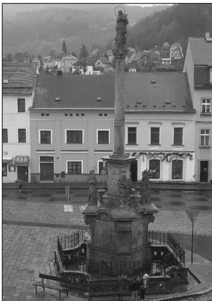
Začala 2. etapa restaurování sloupu s Panou Marií Immaculitou na náměstí. Hotovo by mělo být do konce září 2016. Práce provádí restaurátor Miroslav Žán.
