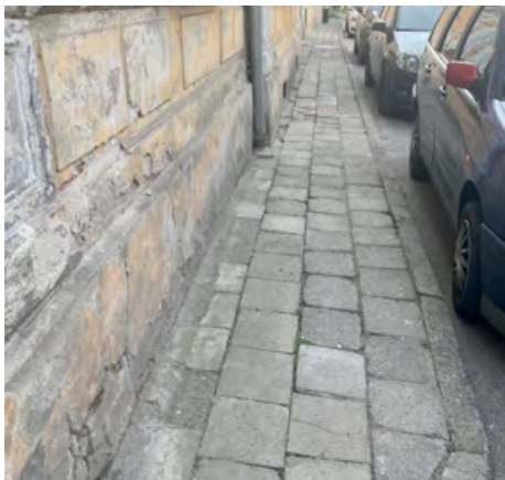
Oprava chodníku v Nerudově ulici.
