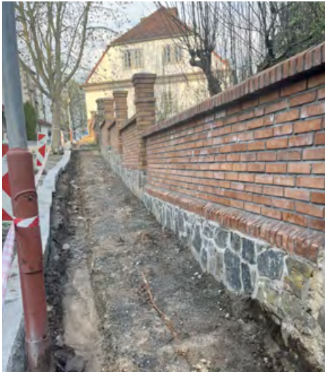
Oprava chodníku v Kostelní ulici.
