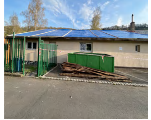
Oprava střechy objektu na koupališti.
