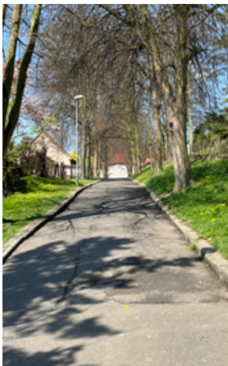
Rekonstrukce cesty Komenského.
