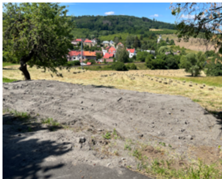
Výstavba turistického přístřešku.
