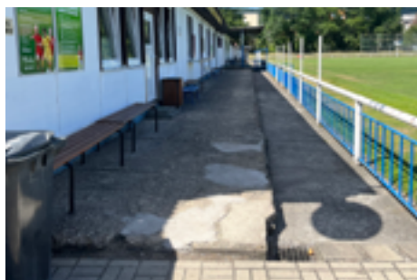
Rekonstrukce chodníku kolem kabin MSK.
