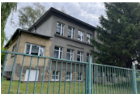
Výměna otopné soustavy.
