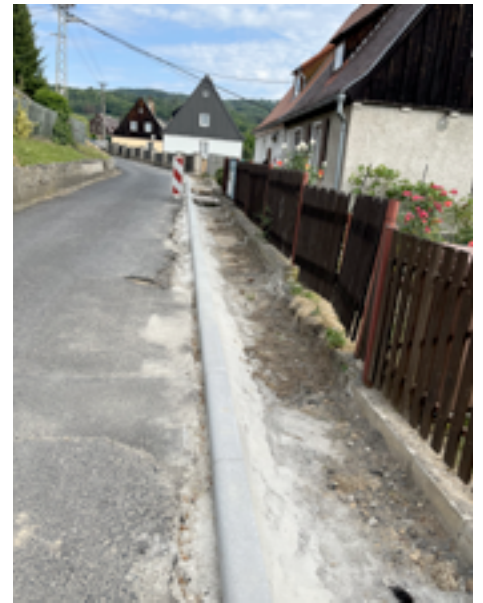
Rekonstrukce chodníků na Tábořském vrchu.
