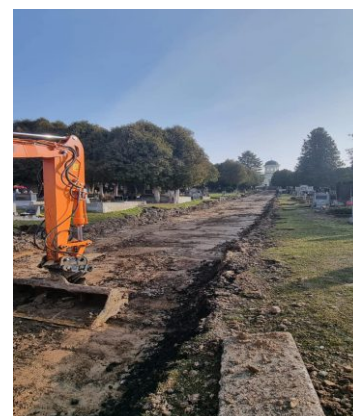
Odkrytí vrchní vrstvy cesty na hřbitov.
